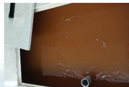
⑧ [設置前] インキローラーチラータンク
